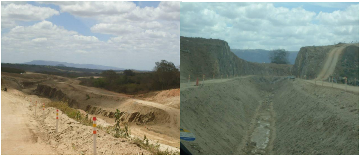
Fotografia 4 - Trecho de Canal em construção no município de Mogeiro-PB.
