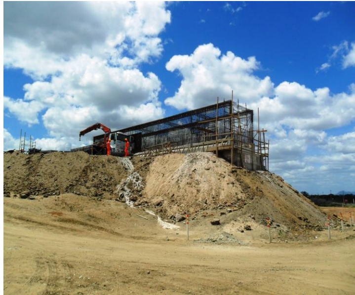
Fotografia 3 - Trecho da obra no cruzamento com a rodovia PB-066.
