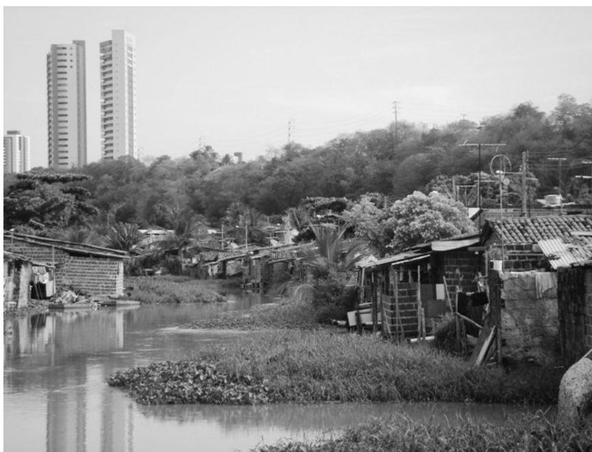
Figura 15 – Favela São José ocupação do leito do rio Jaguaribe, área de risco para mais de 1.300 famílias. Foto: Jocélio Araújo dos Santos, fevereiro de 2007.
