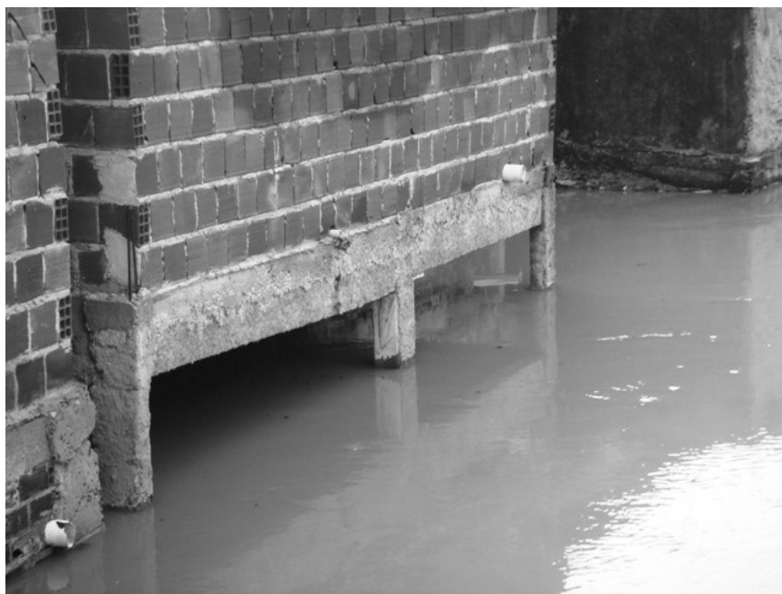
Figura 40 – Margem direita – vigas em concreto armado dando sustentação a uma moradia construída em alvenaria e possibilitando a permanência do morador na área. Foto: Jocélio Araújo dos Santos, fevereiro de 2007.
