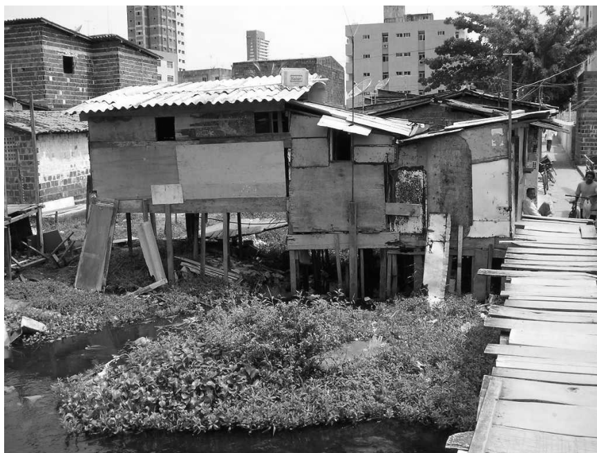
Figura 6 – Moradia construída com resto de material encontrado, caracterizando a precariedade da habitação, bem como, o uso da autoconstrução na favela São José. Foto: Jocélio Araújo dos Santos, janeiro de 2004.
