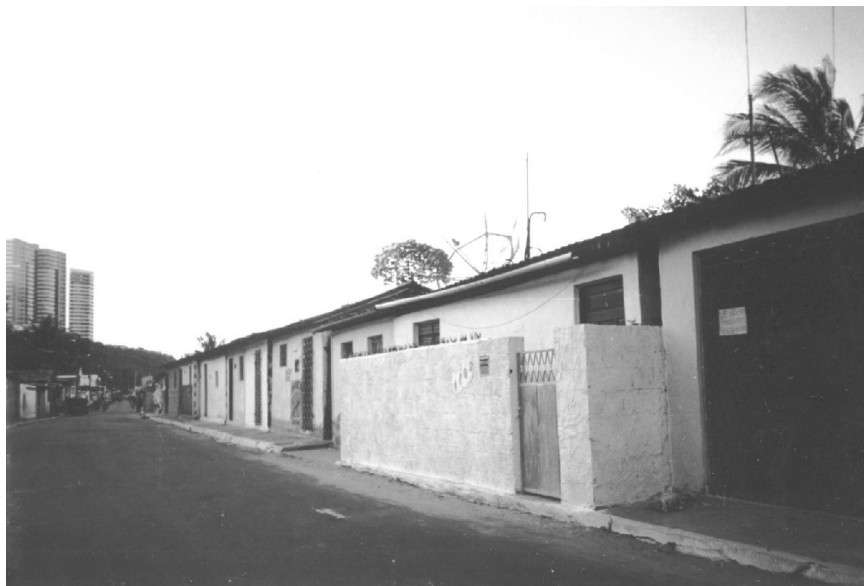
Figura 7 – Casas construídas em alvenaria, na Rua Edmundo Filho caracterizando o limite dos rendimentos dos moradores e até mesmo das oportunidades diferenciadas dadas aos moradores, se comparado com a Figura 06. Foto: Marcos Lima (2000).
