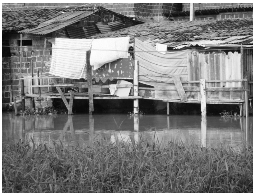
Figura 39 – Margem esquerda – vigas em madeira dando sustentação a parte da casa e possibilitando a permanência do morador na área. Foto: Jocélio Araújo dos Santos, fevereiro de 2007.
