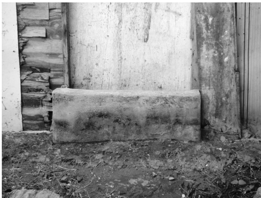
Figura 37 – Presença de dispositivos de proteção de portas nas residências localizadas próximas ao rio Jaguaribe, favela São José. Foto: Jocélio Araújo dos Santos, fevereiro de 2007.
