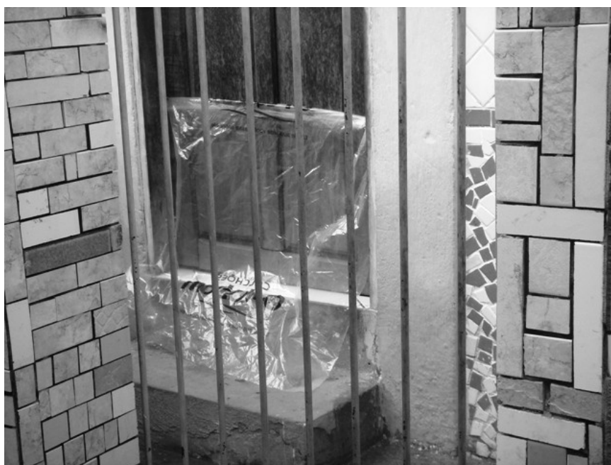
Figura 38 – Alicerce de aproximadamente 60cm de altura. Forma encontrada pelos moradores para fixarem as moradias próximas ao rio, favela São José. Foto: Jocélio Araújo dos Santos, fevereiro de 2007.
