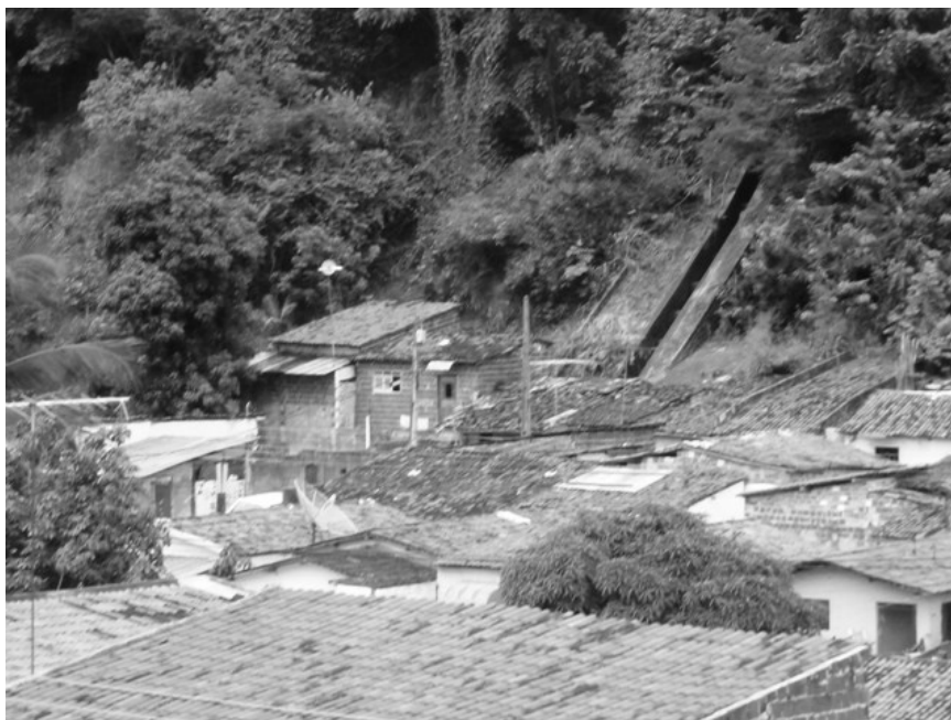
Figura 30 – Observamos no centro da fotografia a escadaria que destina a receber as águas pluviais, dos bairros acima da barreira. Foto: Jocélio Araújo dos Santos, fevereiro de 2007.
