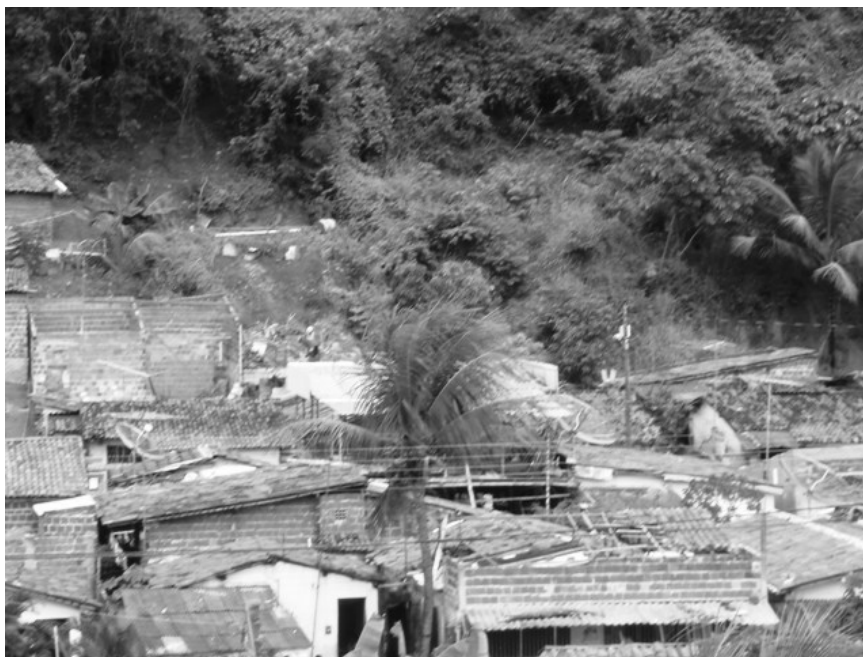
Figura 27 – Clareiras abertas na encosta da favela São José para da lugar as habitações. Foto: Jocélio Araújo dos Santos, fevereiro de 2007.
