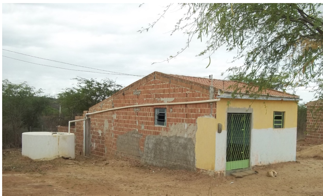
Figura 2 - Cisterna de Placas mapeada na zona rural de Juazeirinho PB – a água da chuva é captada através do telhado da casa e depositada na cisterna. Foto: Cristhiane Fernandes, novembro de 2011.
