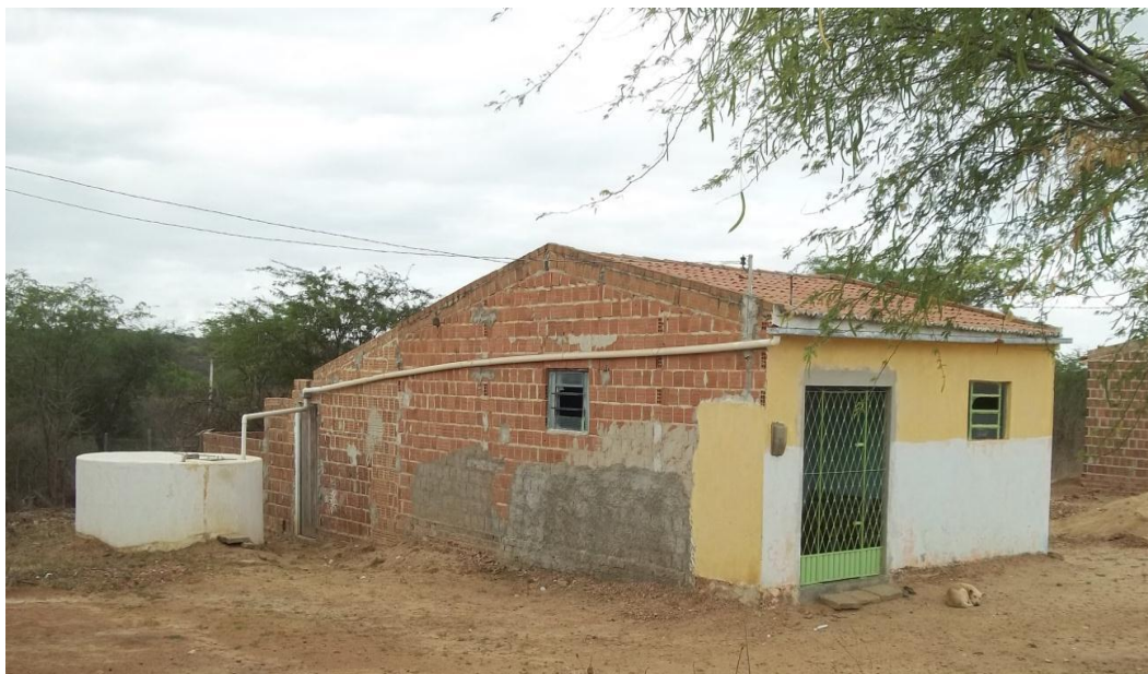
Figura 3 - Cisterna de Placas mapeada na zona rural de Juazeirinho PB – a água da chuva é captada através do telhado da casa e depositada na cisterna. Foto: Cristhiane Fernandes, novembro de 2011.
