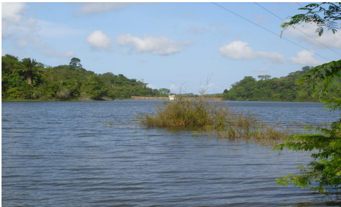
Figura 28 - Aspecto geral da Barragem do Bita no município de Ipojuca/PE – margens protegidas Foto: Enildo Gouveia/Shinaide Lopes (Outubro/2008)
