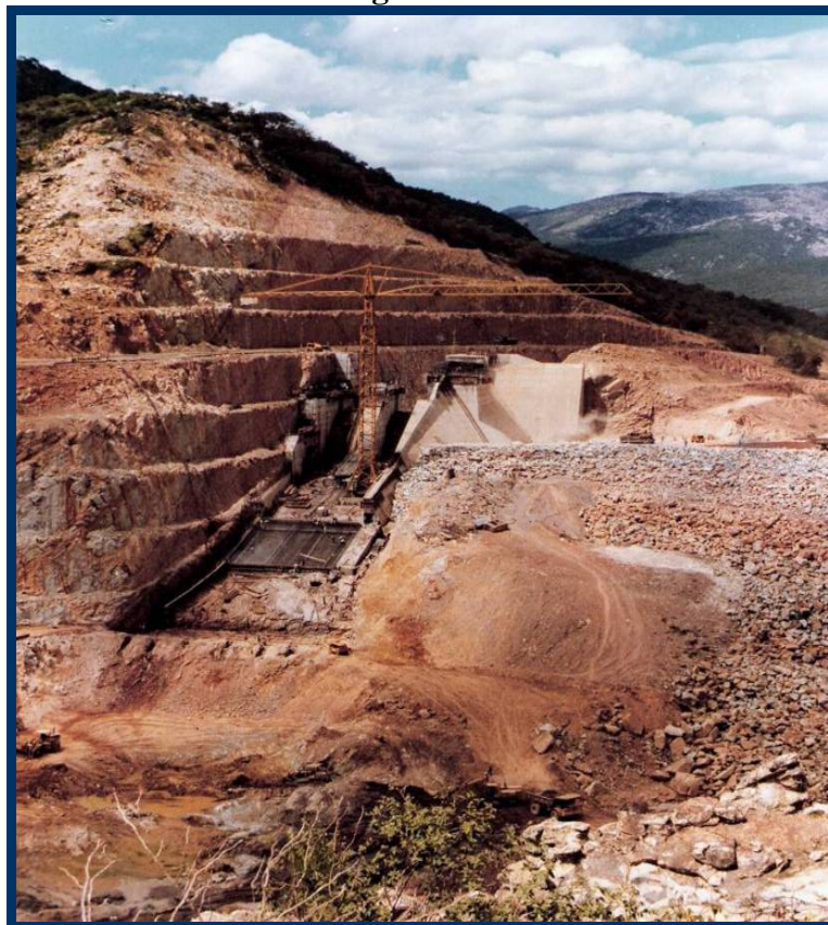
Construção da Barragem Manoel Novais (Mirorós)
