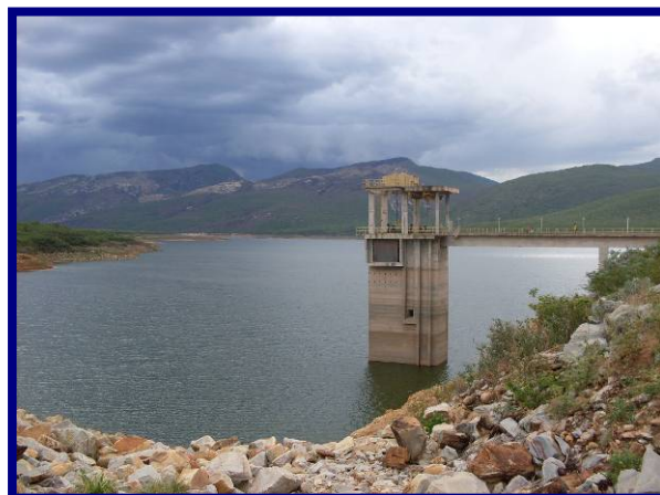
Torre de tomada d'água, barragem de Mirorós. Dezembro de 2008. Foto – Tássio Cunha
