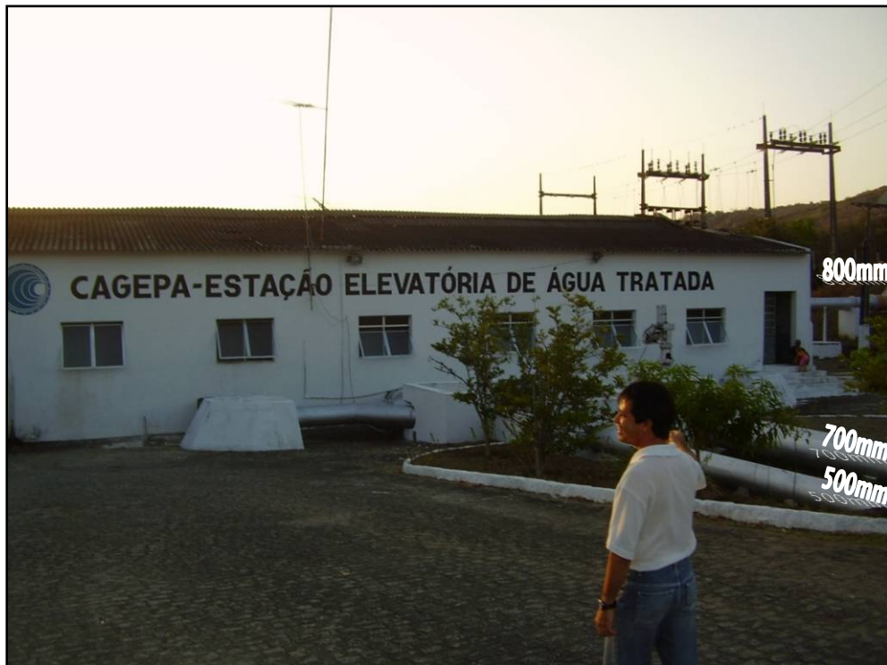
Figura 36 – Estação de distribuição da água já tratada para atender ao abastecimento com saída de três adutoras: 500, 700 e 800 mm – Gravatá, Município de Queimadas. (Franklyn, 07/01/2008)
