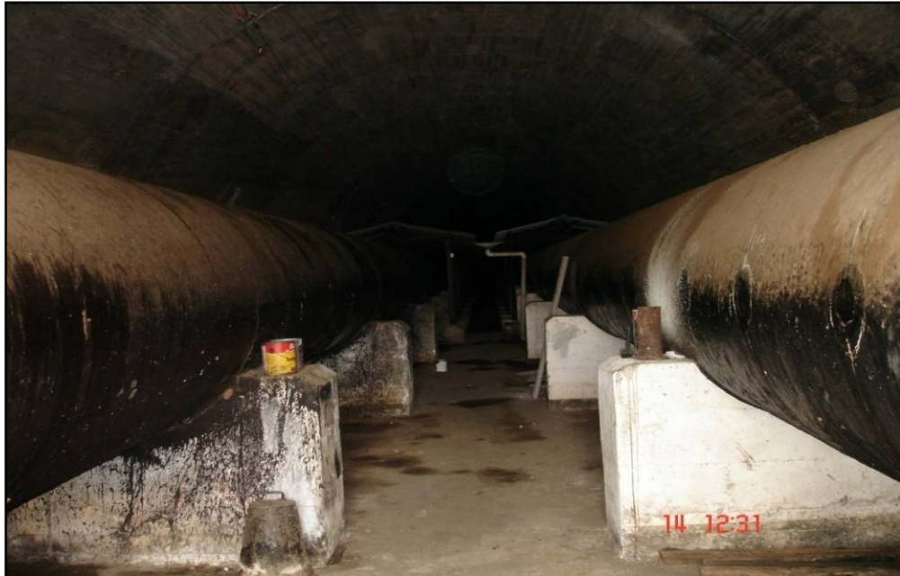
Figura 32 – Túnel de passagem das adutoras que partem da torre (Franklyn, 14/10/2007).
