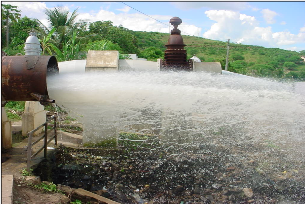
Figura 11 – Comporta de descarga aberta perenizando o Rio Paraíba, município de Boqueirão (AESA, 1997).
