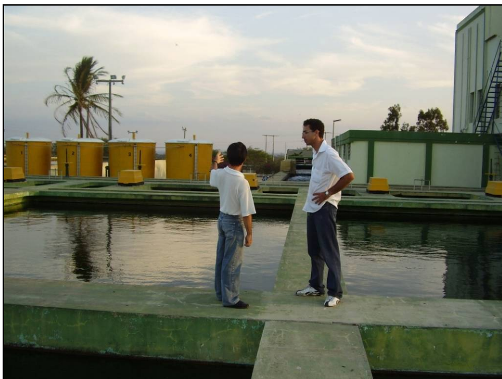
Figura 35 – Sistema de Tratamento de Água: Gravatá, Município de Queimadas (Napoleão, 07/01/ 2008)
