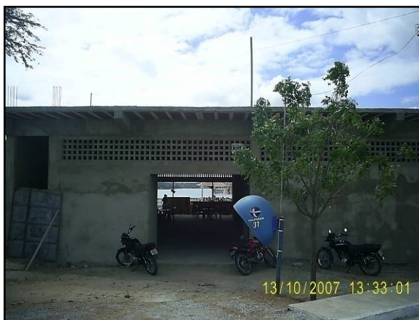
Figura 44 - Reforma no Restaurante Margens das Águas, município de Boqueirão (Franklyn)
