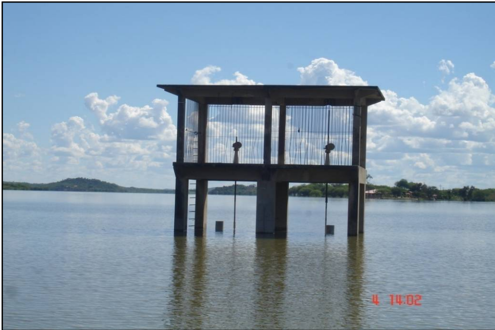
Figura 31 – Torre de tomada d' água – Boqueirão (Franklyn, 04/04/2008).
