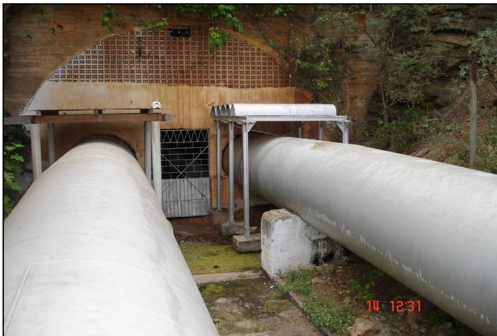
Figura 33 – Saída das adutoras do túnel com destino aos sistemas de tratamento, Município de Boqueirão (Franklyn, 14/10/2007)
