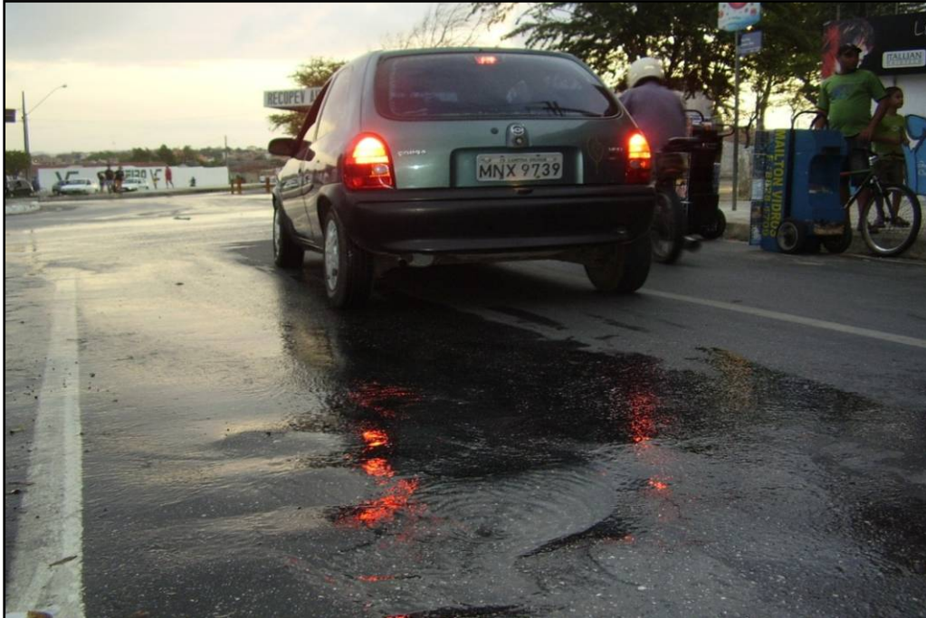
Figura 60 – Vazamento na encanação da rede de abastecimento d' água, Rua Costa e Silva, Cruzeiro – Campina Grande. (Franklyn, 14/01/2008)
