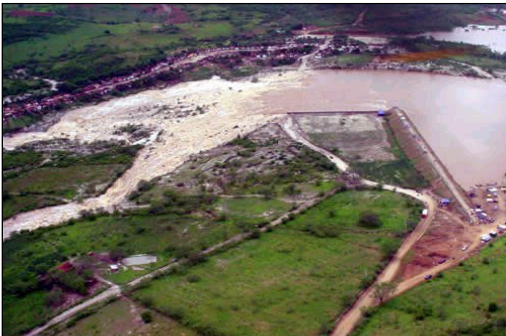
Figura 53 – Vista aérea do vertedouro “sangrando”, município de Boqueirão (AESAs, 2004)
