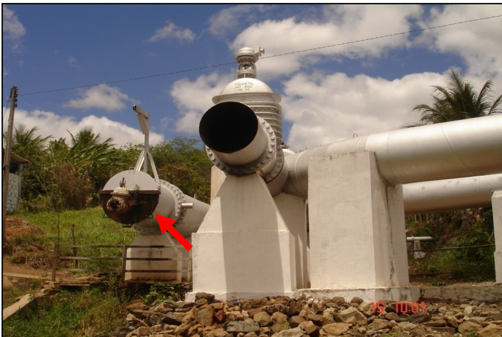
Figura 17 – Comporta de descarga fechada, Município de Boqueirão (Franklyn, 15.10.2007)
