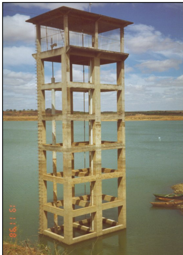
Figura 02 - Torre de tomada d'água (AES, 1998)
