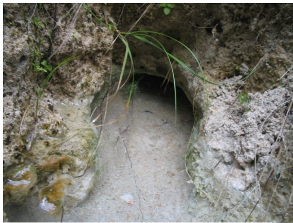
Foto II - Ocorrência de tubos de Piping . Foto: Valéria Raquel Porto.
