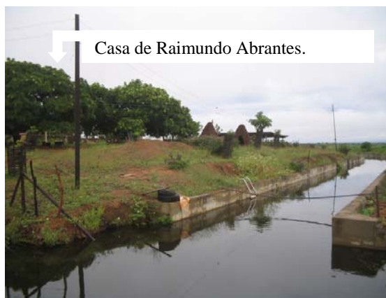
Foto 05: local onde o canal segue para a estação elevatória. Ao lado da propriedade do agricultor. Fonte: Jorge Flávio Cazé. Março de 2005.
