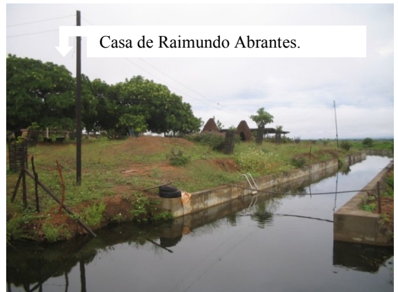
Foto 4: local onde o canal segue para a estação elevatória. Ao lado da propriedade do agricultor. Fonte: Jorge Flávio Cazé. Março de 2005.
