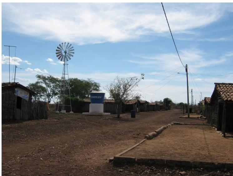
Foto 24: Sistema de abastecimento de água no acampamento Nova Vida I, outubro de 2008. Fonte: Valéria R. P. de Lima.
