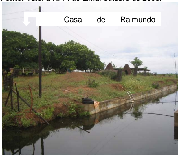
Foto 34: local onde o canal segue para a estação elevatória. Ao lado, propriedade do agricultor. Fonte: Jorge Flávio Cazé. Março de 2005.
