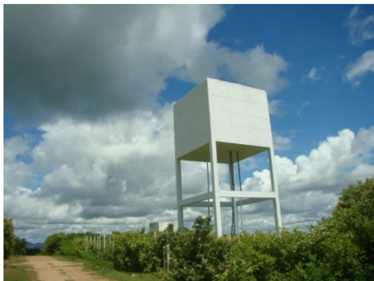
Foto 16: Caixa d'água no assentamento Acauã. Fonte: Valéria R. P. de Lima. Outubro de 2008.
