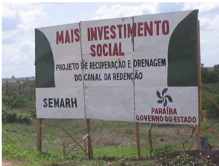
Foto 29: Placa sinalizando obra de recuperação do Canal da Redenção. Fonte: Valéria R. P. de Lima. Março de 2005.
