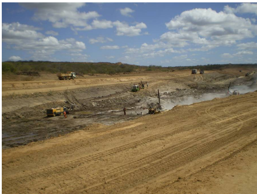
Foto 3 – Construção do canal de transposição do rio São Francisco na cidade de Cabrobó – PE.
