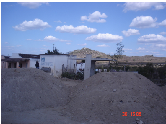
Figura 31: Obra de pavimentação da estrada de Alagoinha - PE ao distrito de Perpétuo Socorro. Autoria: Avani Torres, janeiro de 2007.
