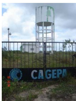
Figura 39: Instalações da CAGEPA desativada em Marcação - PB. Autoria: Avani Torres, novembro de 2006.
