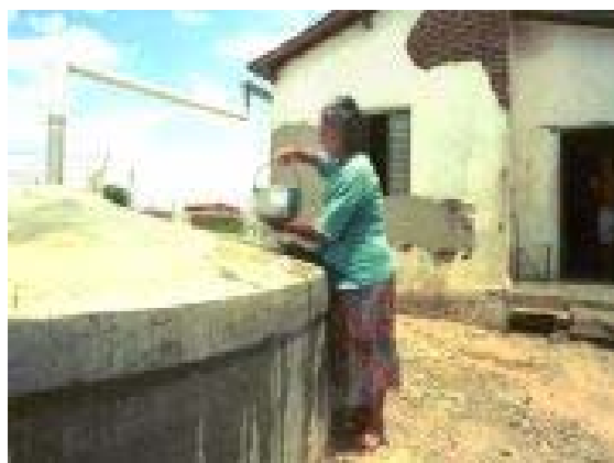
Figura 14: Cisterna de Placas
