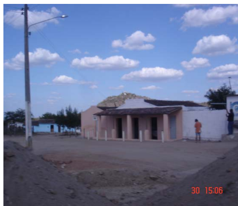
Figura 32: Detalhe da estrada de Alagoinha - PE ao distrito de Perpétuo Socorro. Fotos: Avani Torres, janeiro de 2007.
