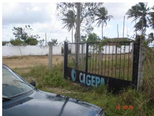
Figura 40: Detalhe das instalações da CAGEPA próxima ao Cemitério Local. Autoria: Avani Torres, novembro de 2006.
