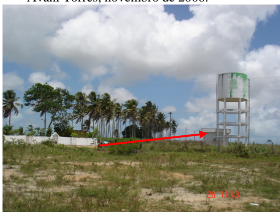
Figura 41: Distância entre o poço e o cemitério. Autoria: Avani Torres, novembro de 2006.
